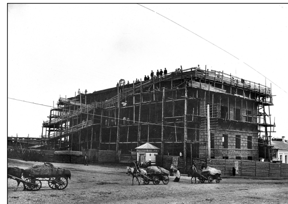
Строительство здания Музея промышленности и искусства. 1913
